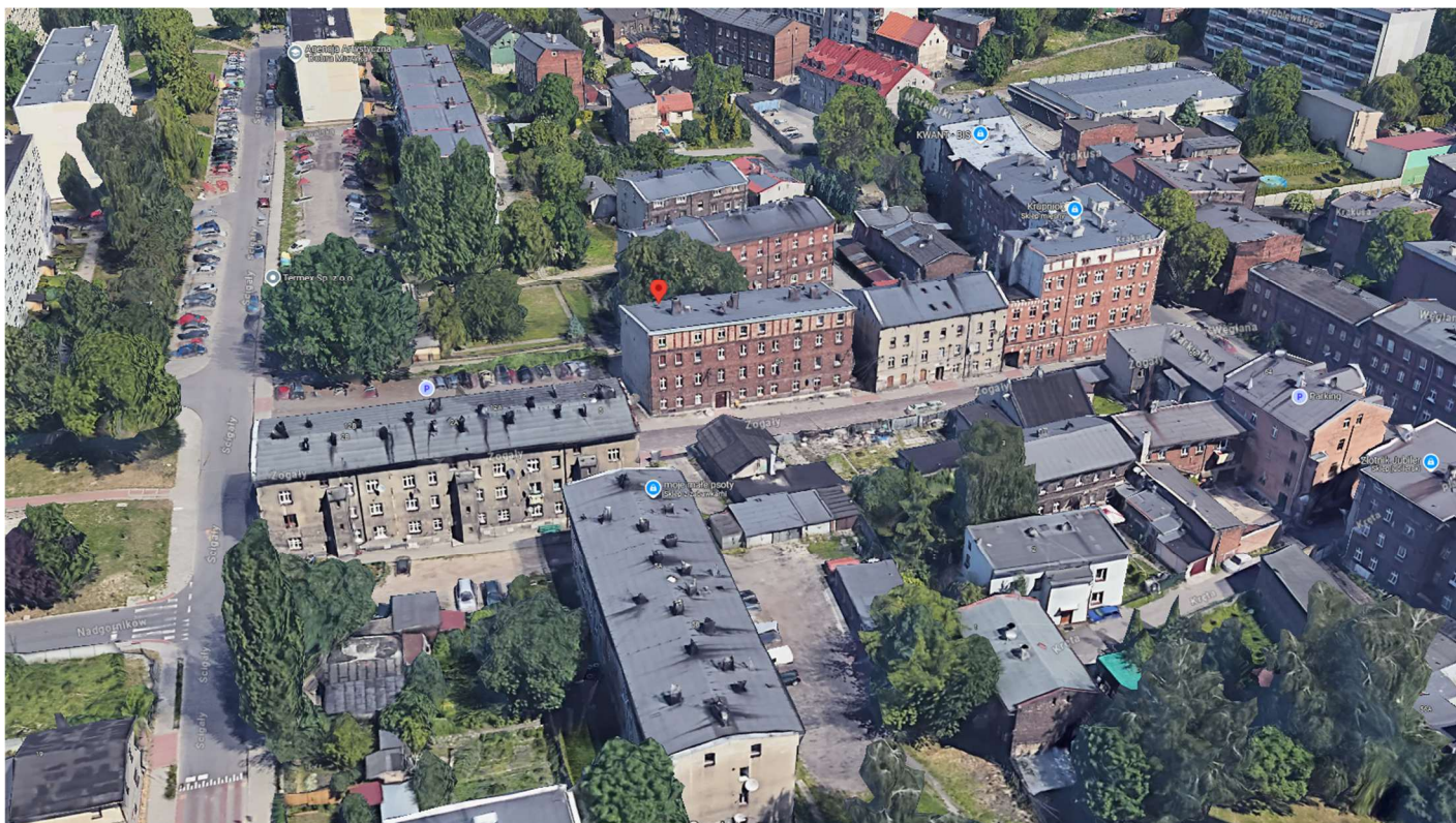
Rys 2. Lokalizacja przedmiotowego budynku – widok z lotu ptaka
